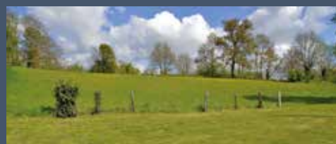
Een goed bewaard deel van het aquaduct in Tongeren.
