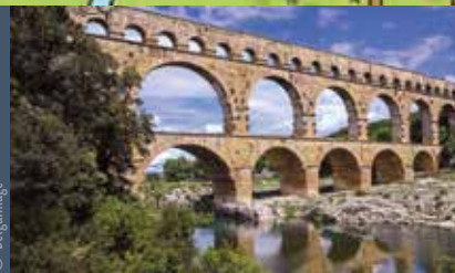
De Pont du Gard in Frankrijk: sinds de middeleeuwen is het aquaduct een brug.
